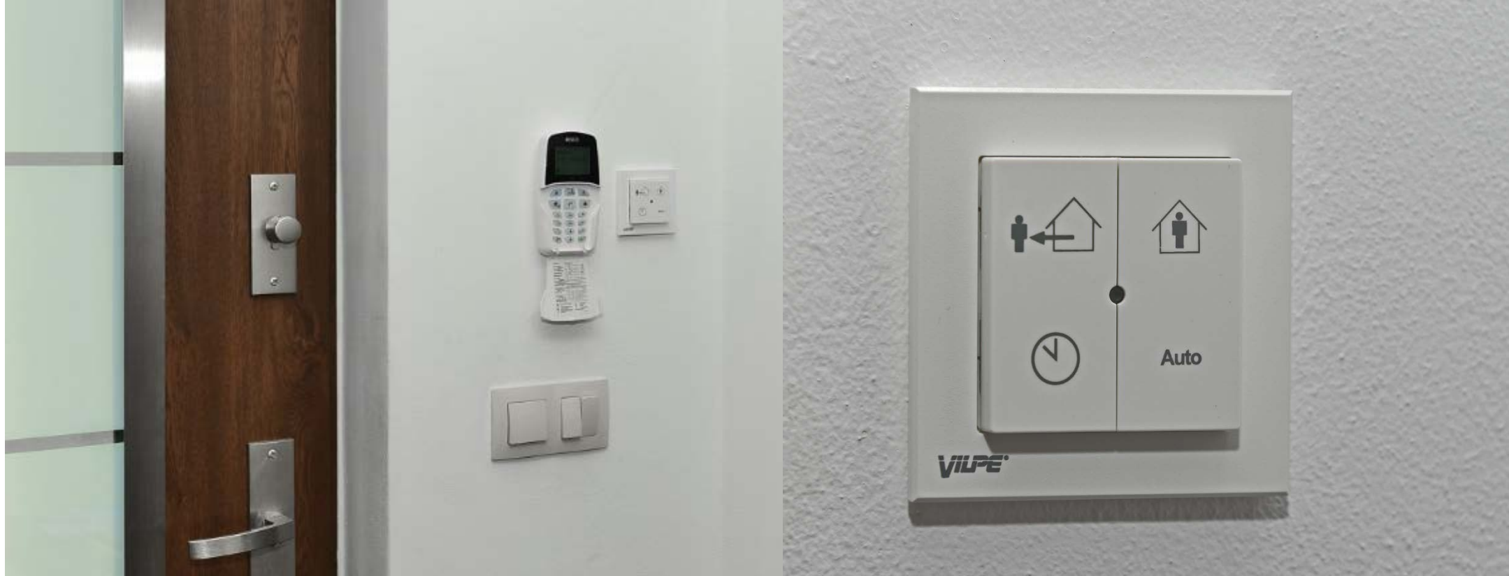
Fali vezérlő (CU) a nappaliban A VILPE® ECo Ideal Wireless szellőztető rendszerhez
